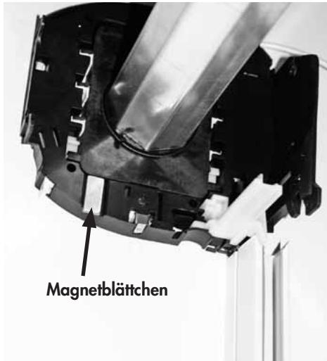
Nachdem Sie den Revisionsdeckel vom Kasten entfernt haben, merken Sie sich die Motorseite mit dem Kabelausgang.
